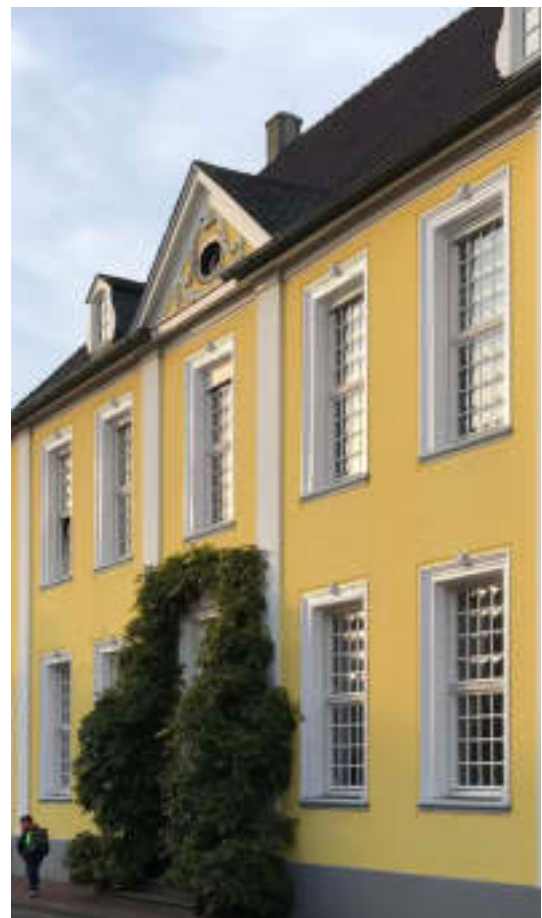
...und Zwerchhaus an historisch wertvollen Gebäuden in Issum
