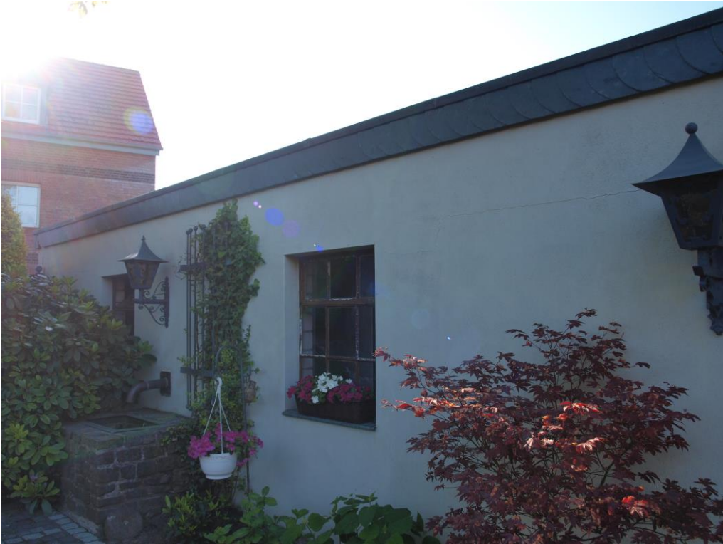
Foto 5: Gemauertes Nebengebäude bzw. Garage innerhalb des Änderungsbe- reichs
