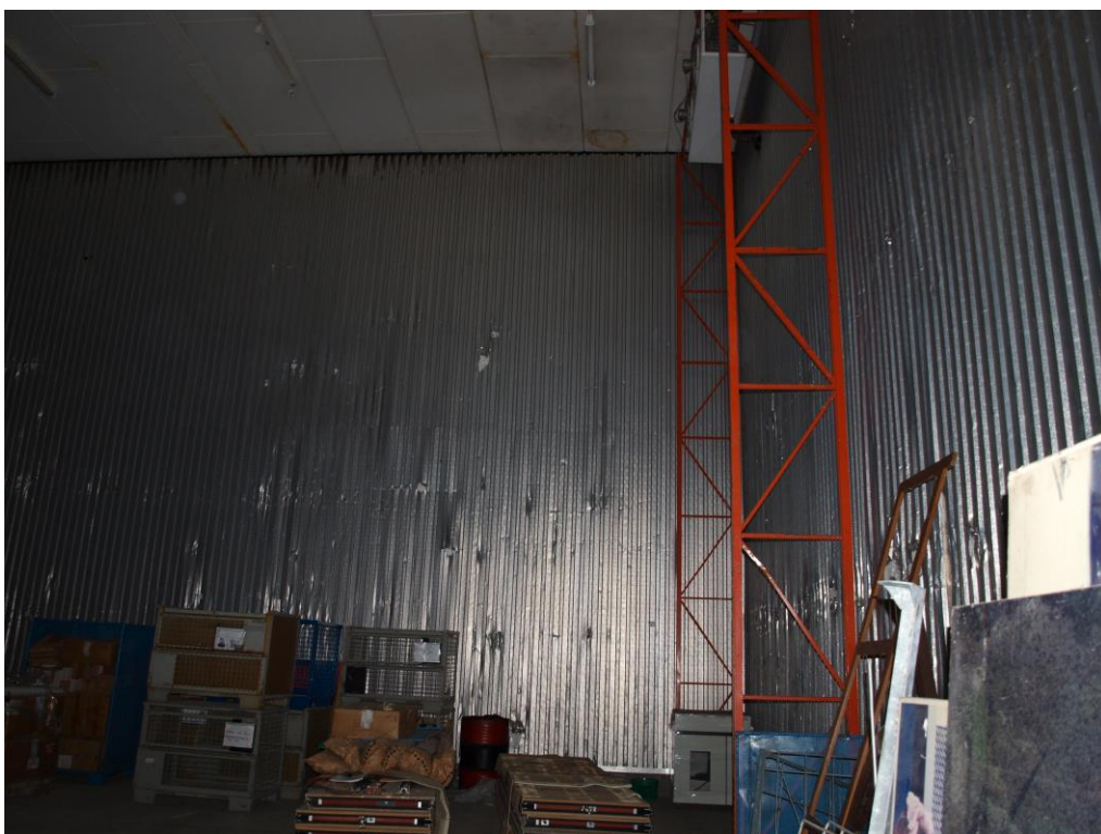
Foto 8: Südlicher Gebäudeteil der Werkstatt mit Lagerraum
