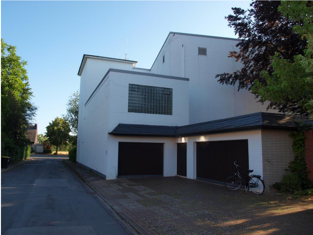
Foto 1: Blick entlang der Werkstraße auf das nördliche Plangebiet mit leerstehendem ehem. Werkstattgebäude
