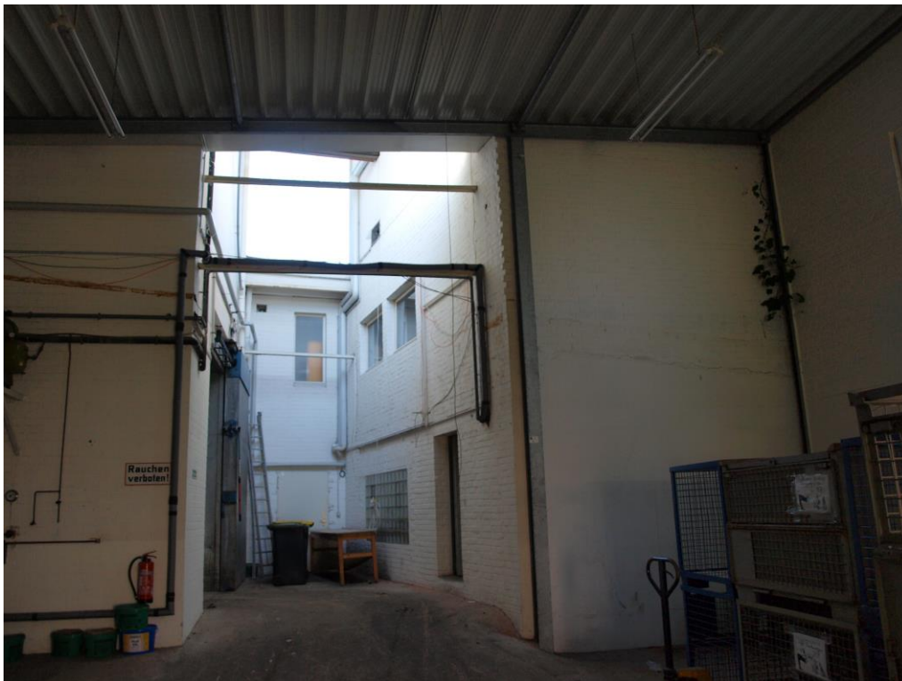
Foto 7: Innenräume des Werkstattgebäudes
