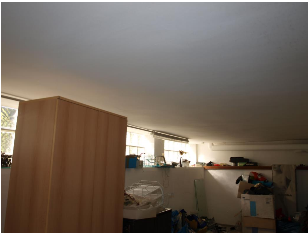
Foto 10: Östliches Nebengebäude mit Wirtschafts-/Lagerraum
