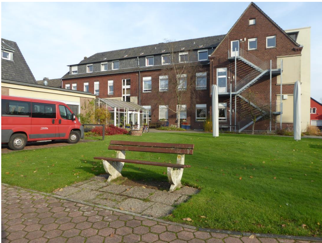
Foto 4: Blick von Westen auf das St. Josef-Haus und die Anbauten.
