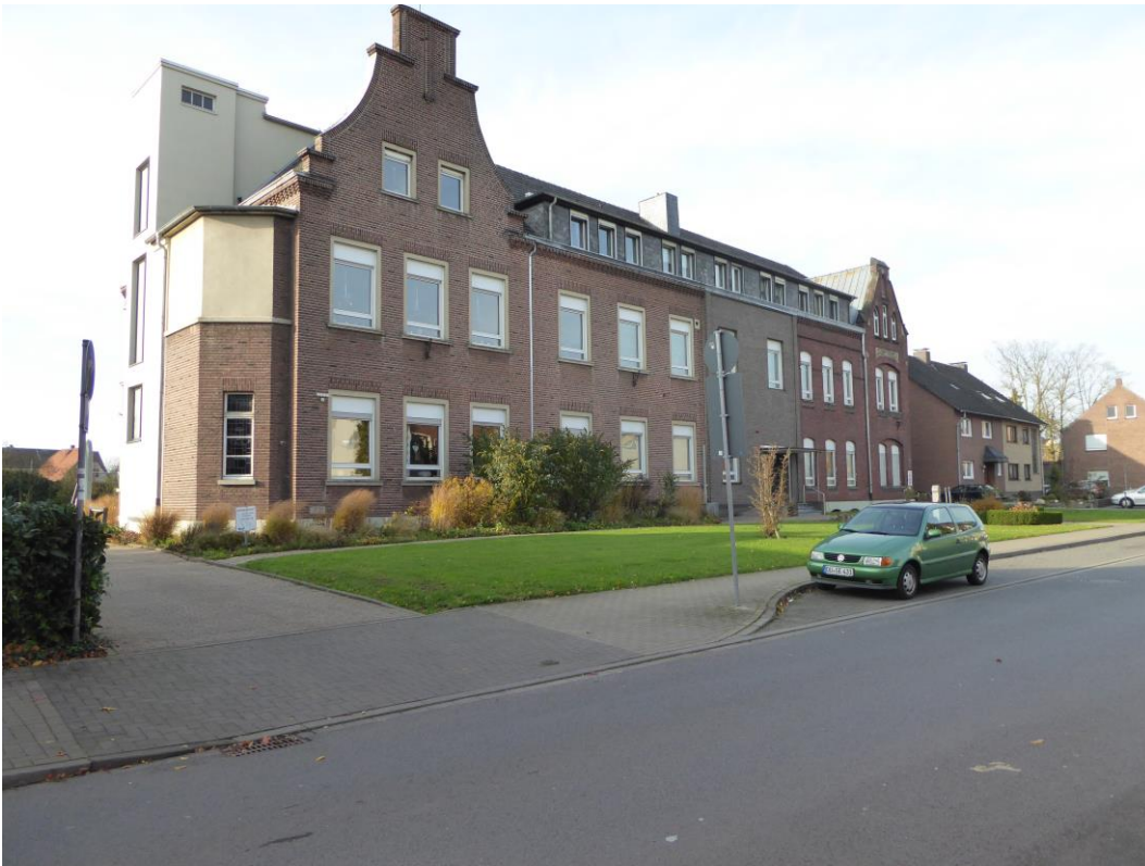
Foto 1: Blick von Osten (Kapellener Straße) auf das bestehende St. Josef-Haus.
